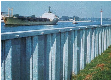
Abb. 59: Schutzgeländer einer Schleusenanlage (Spundwand)
